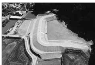
決壊を未然に防ぐために改修された 農業用ため池
