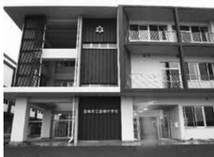
被災により建て替えた益城中学校新校舎
