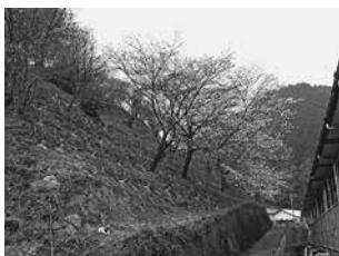
ユニットネット工法 施工現場 (福岡県)
