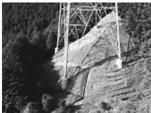
送電鉄塔傾斜に敷き詰めた雨水誘導マット
