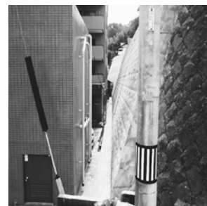
熊本地震で既存石垣崩壊の現場復旧工事
