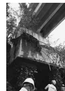
令和2年7月豪雨での災害対応・橋梁点検調査
