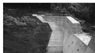
布製型枠に流動性コンクリート又はモルタルを圧入するコンクリート体成工法です。
