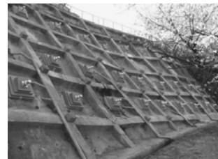
EHDアンカーとFFU受圧板の施工例
