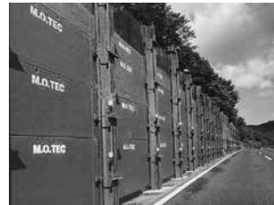
「パネル式防護柵(支柱基礎式)」設置状況
