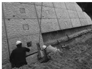
PC鋼棒によるパネルの緊張連結(逆巻き)
