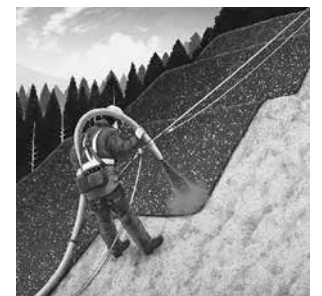
ノンラスグリーン工法
