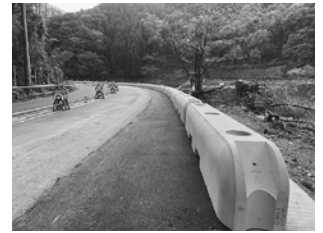
被災時など早期道路復旧(球磨川災害)
