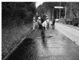
ラバファルト塗布状況
