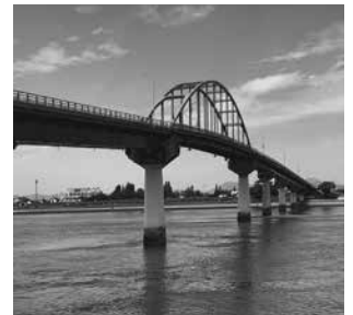
2018年7月施工新田大橋補修工経年写真
