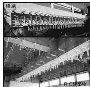
IPH工法による橋梁・RC建築物補修工事
