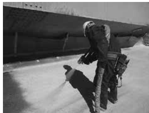
コンクリートへのポリウレタ吹付け状況
