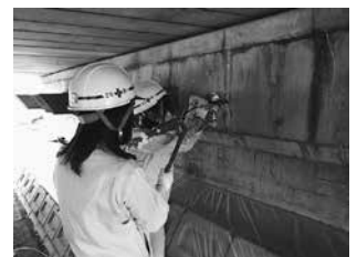
圧力調整注入工法
