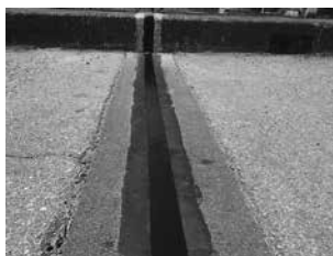
SMジョイント(ゴム劣化取替工法)
