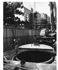
既設水槽を活かして再生するTIT工法
