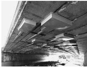
福岡201号新唐子橋上部工工事(福岡県)
