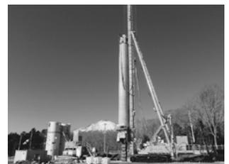
CCC掘削装置を汎用の三式式杭打機に搭載
